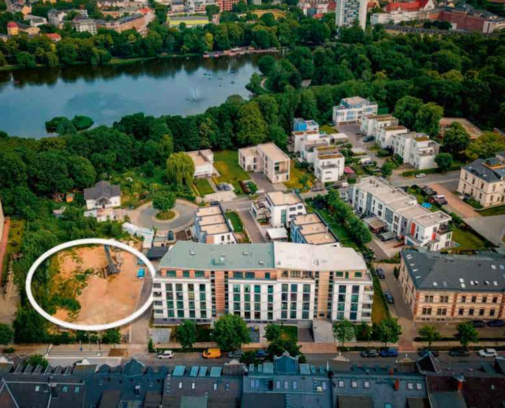
Dort, wo der weiße Kreis eingezeichnet ist, baut die FASA AG das Solardomizil III. Rechts daneben steht die zweiteilige Wohnanlage Solardomizil I und II.
