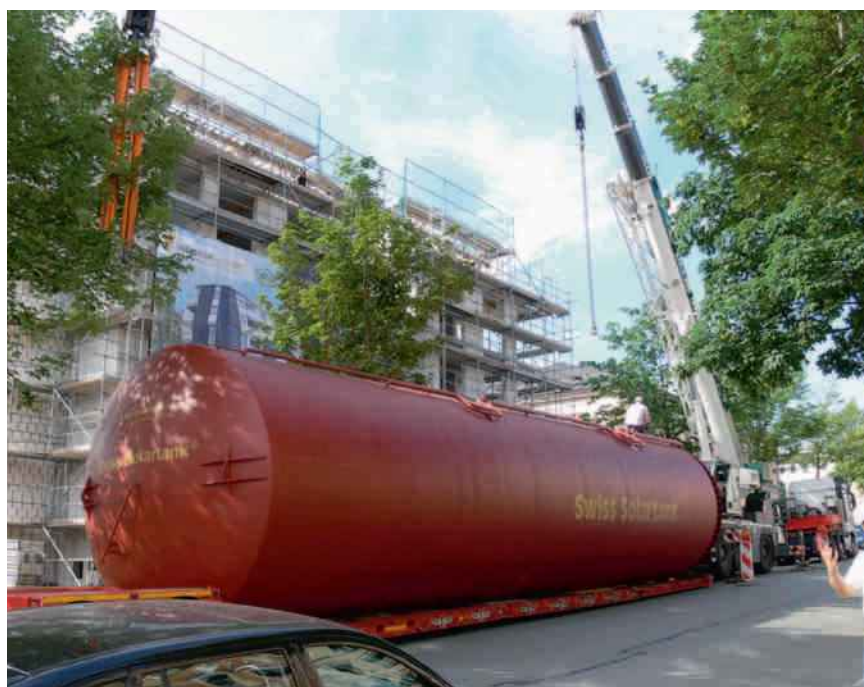
Beachtliche Dimensionen: Der Wärmespeicher von Jenni Energietechnik im Solardomizil III fasst 72 Kubikmeter Wasser und ist knapp 18 Meter hoch. FOTO: VOLKMER ZICHERNER
