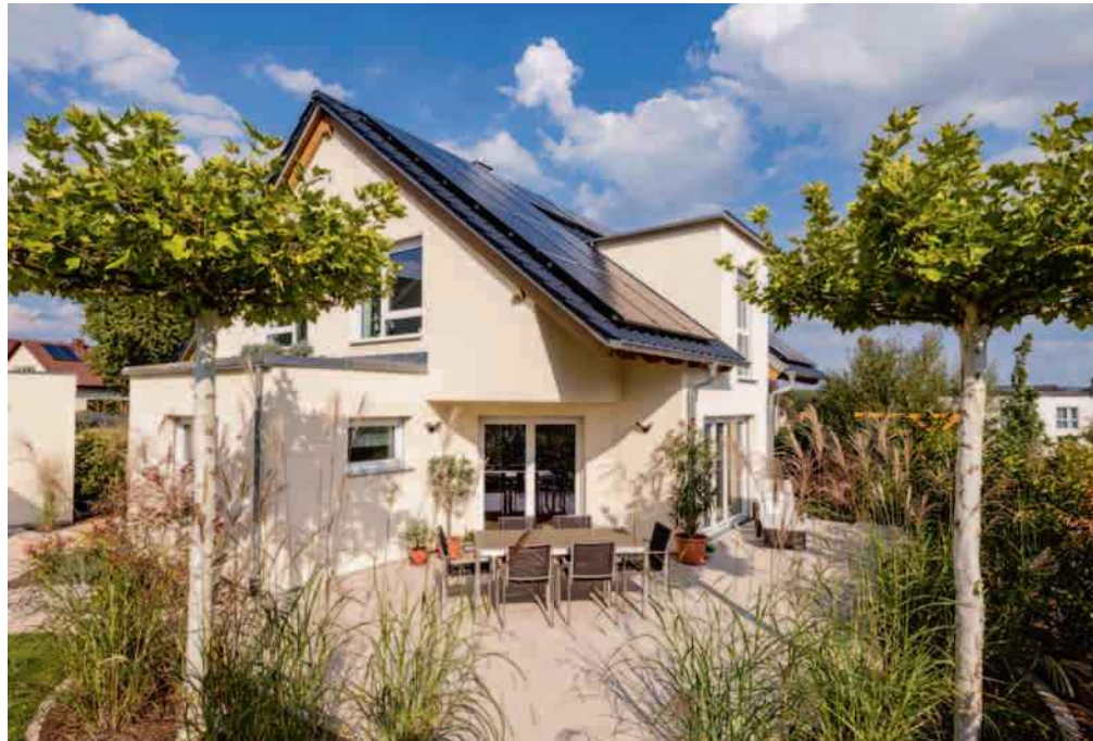
Sonnenhaus mit Photovoltaik und solarstromgeführter Wärmepumpe.
