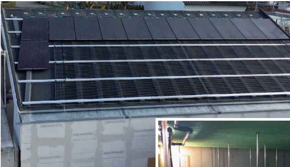
Abb. 4: Installation der PVT-Kollektoren (links) und Innenansicht des Eisspeichers (rechts)
