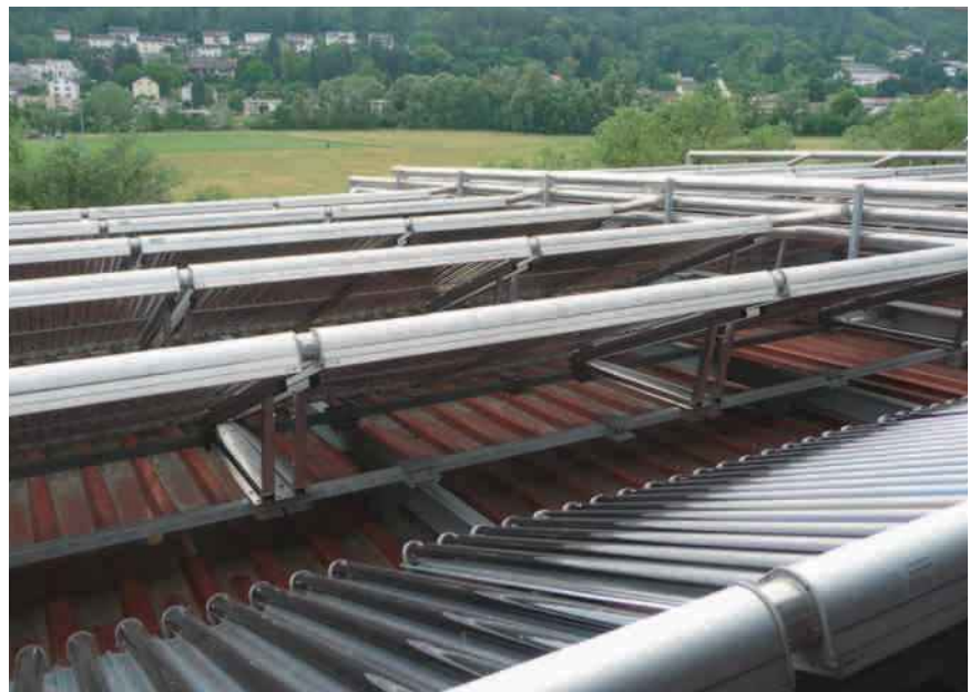
Die solarthermische Großanlage für die Privatbrauerei Hofmühl war eine der ersten für die Erzeugung von solarer Prozesswärme. FOTO: JENS-PETER MEYER
