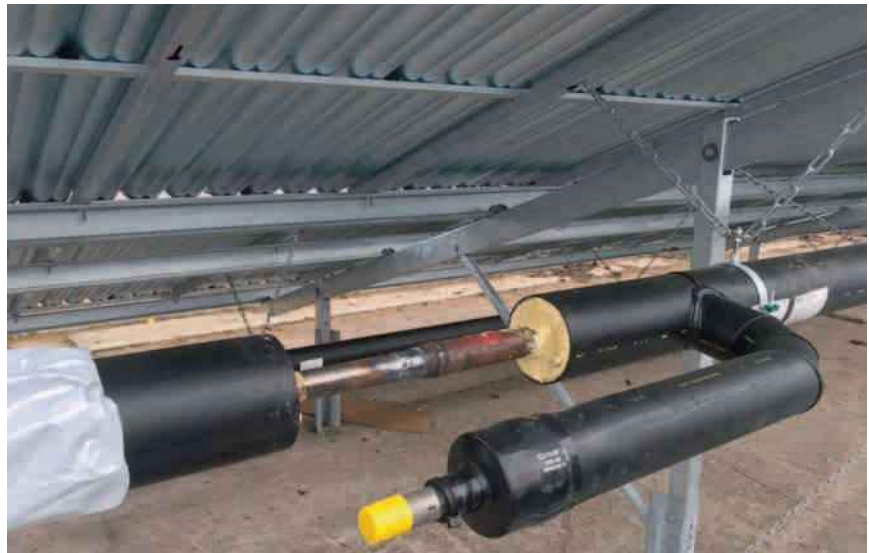
Das Kollektorfeld wurde schon errichtet. Im Vordergrund warten die fertig isolierten Wärmeträgerrohre auf die Verlegung (links). Verbindungsstelle unter den Kollektoren vor dem Isolieren (unten).
