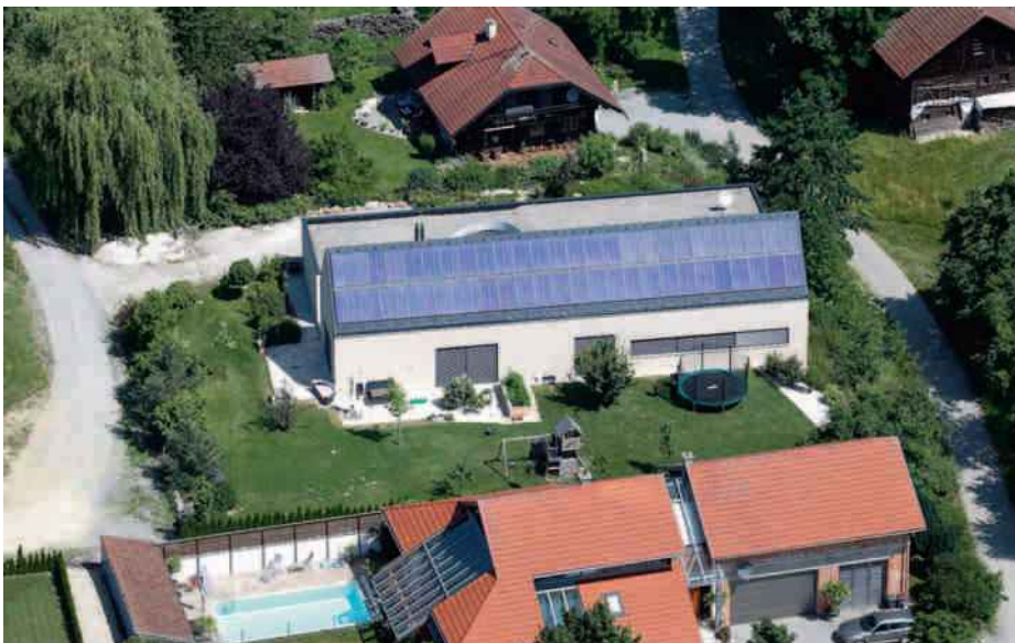
Dieses klassische Sonnenhaus steht im Hausruckviertel in Oberösterreich und ermöglicht den Bewohnern seit sechs Jahren ein Leben von und mit der Sonne. Die Kombination von robuster Haustechnik mit bewährten massiven Materialien wie dem Ziegel mit seiner ausgezeichneten Speicherkapazität und optimalem Temperaturmanagement führt zu einem hohen Wohnkomfort bei geringen Energiekosten.
