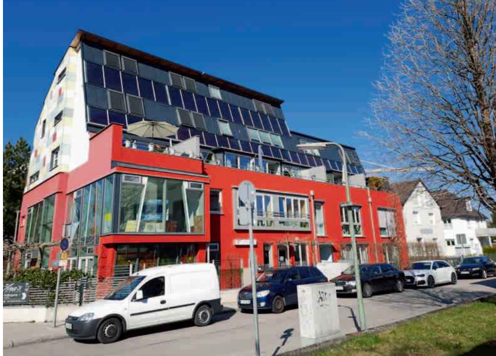
Solarthermie auf einem Wohn- und Geschäftshaus in München
