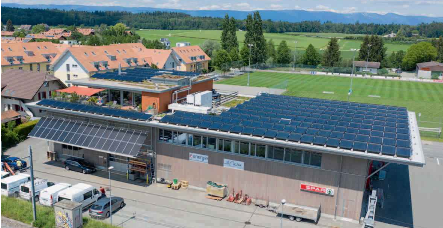
Viel hilft viel: Auf dem Dach des neuen Gewerbehouses Schüpfen Zentrum wurde fast jeder Quadratmeter genutzt, um Vakuumröhrenkollektoren zu installieren. FOTO: A ENERGIE AG
