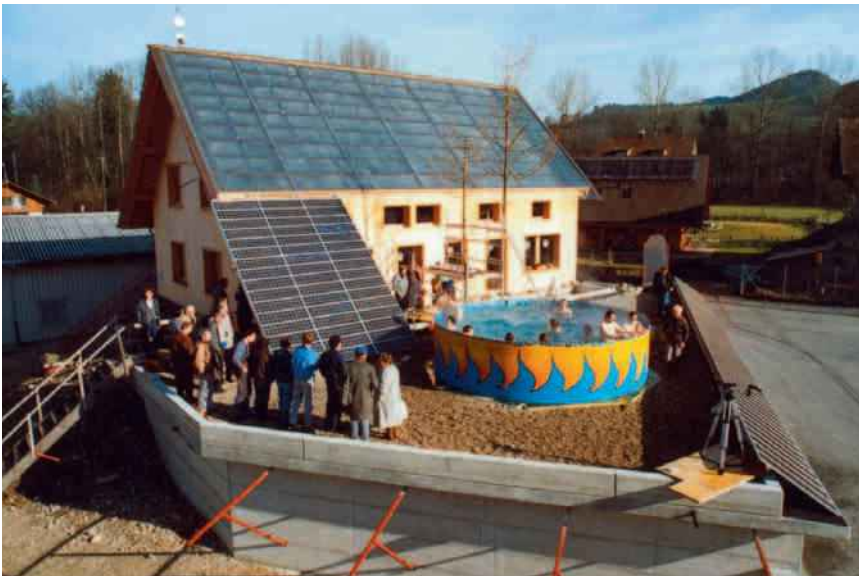
Auf der Südseite des Sonnenhauses in Oberburg wurden 84 m 2 Solarkollektoren und 43 m 2 Photovoltaik installiert. Am 31. Januar 1990 war der solar beheizte Pool ein Spektakel, das die Popularität der Solarenergie enorm steigerte.
