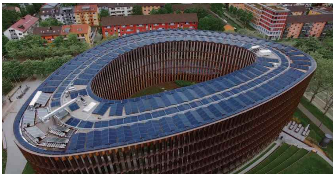
Freiburger Rathaus im Stühlinger: Europas größtes öffentliches Netto-Nullenergiegebäude wird unter anderem von PVT-Kollektoren (links auf dem Dach) versorgt.
