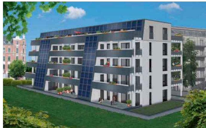
Gartenansicht des Solardomizils III (oben): 340 Quadratmeter Solarkollektoren, die im Februar 2021 installiert wurden (unten), erzeugen Wärme für 24 Eigentumswohnungen. FOTOS (3): FASA AG, ILLUSTRATION: HIRSACK & CO.
