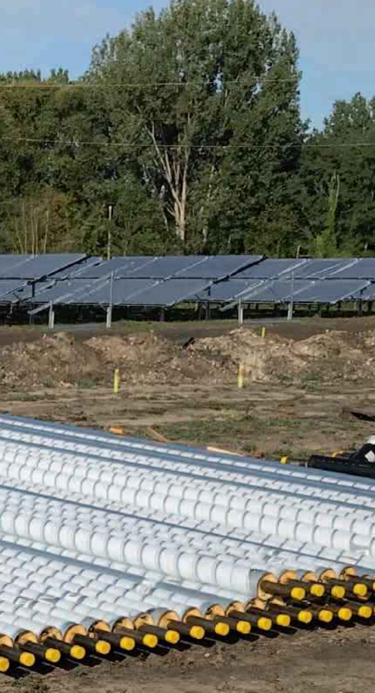
Das Kollektorfeld wurde schon errichtet. Im Vordergrund warten die fertig isolierten Wärmeträgerrohre auf die Verlegung (links). Verbindungsstelle unter den Kollektoren vor dem Isolieren (unten).
