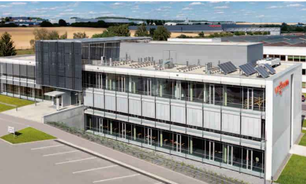
Das Schulungszentrum von Viessmann am Standort Faulquemont gewinnt Wärme mit einer Vakuumröhrenkollektor-Anlage an der Fassade des Eingangsbereichs. FOTO: VISSMANN
