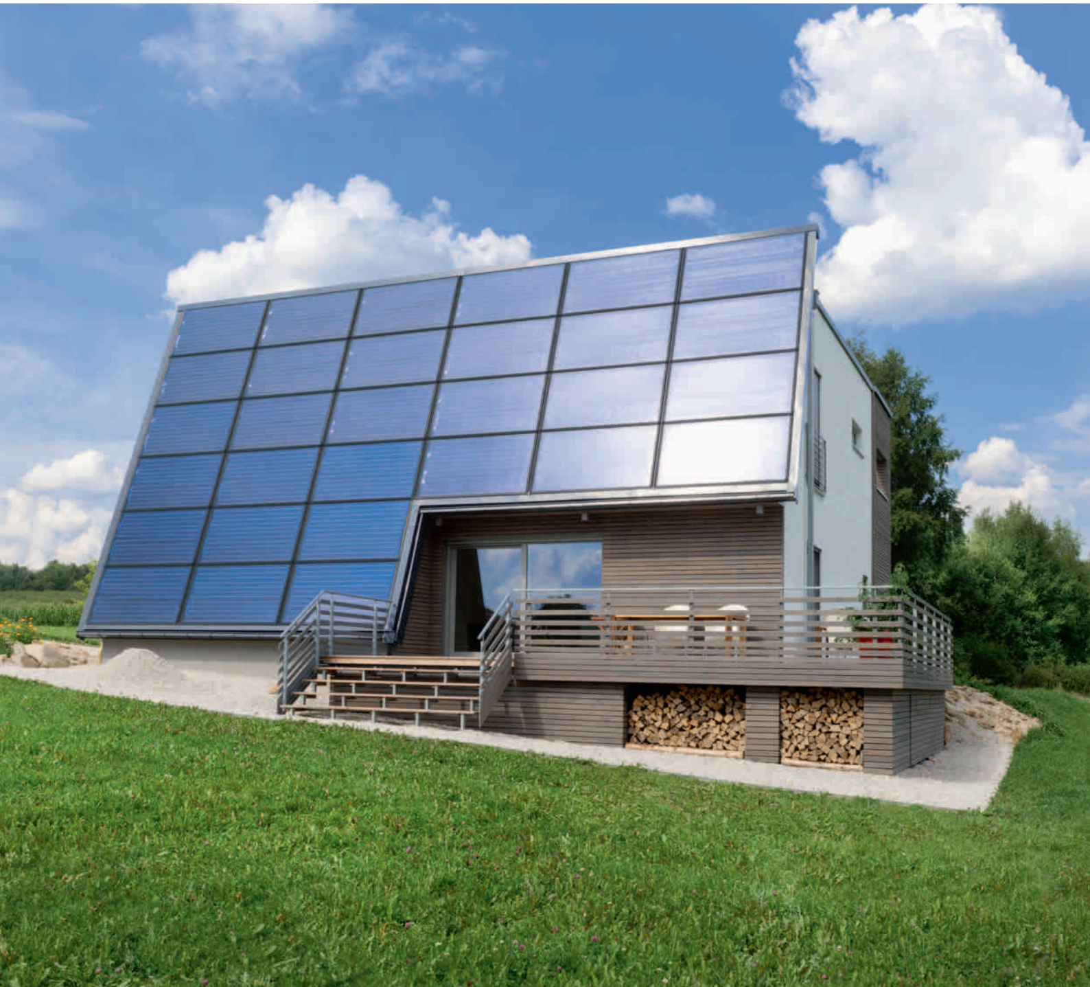
Mit der großen, sehr steilen Solarthermiefläche erreicht die FASA AG solare Deckungsgrade über 90 Prozent in der Wärmeversorgung. Fotos (2): FASA AG
