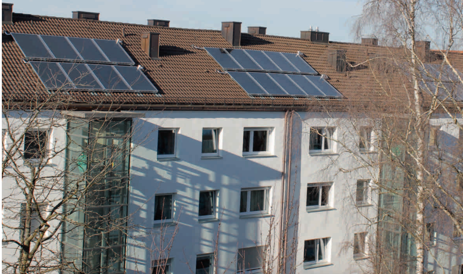
Im Münchner Stadtteil Giesing unterstützen Sonnenkollektoren seit September 2015 die Gasheizung einer Wohnanlage des Bauvereins Giesing.
