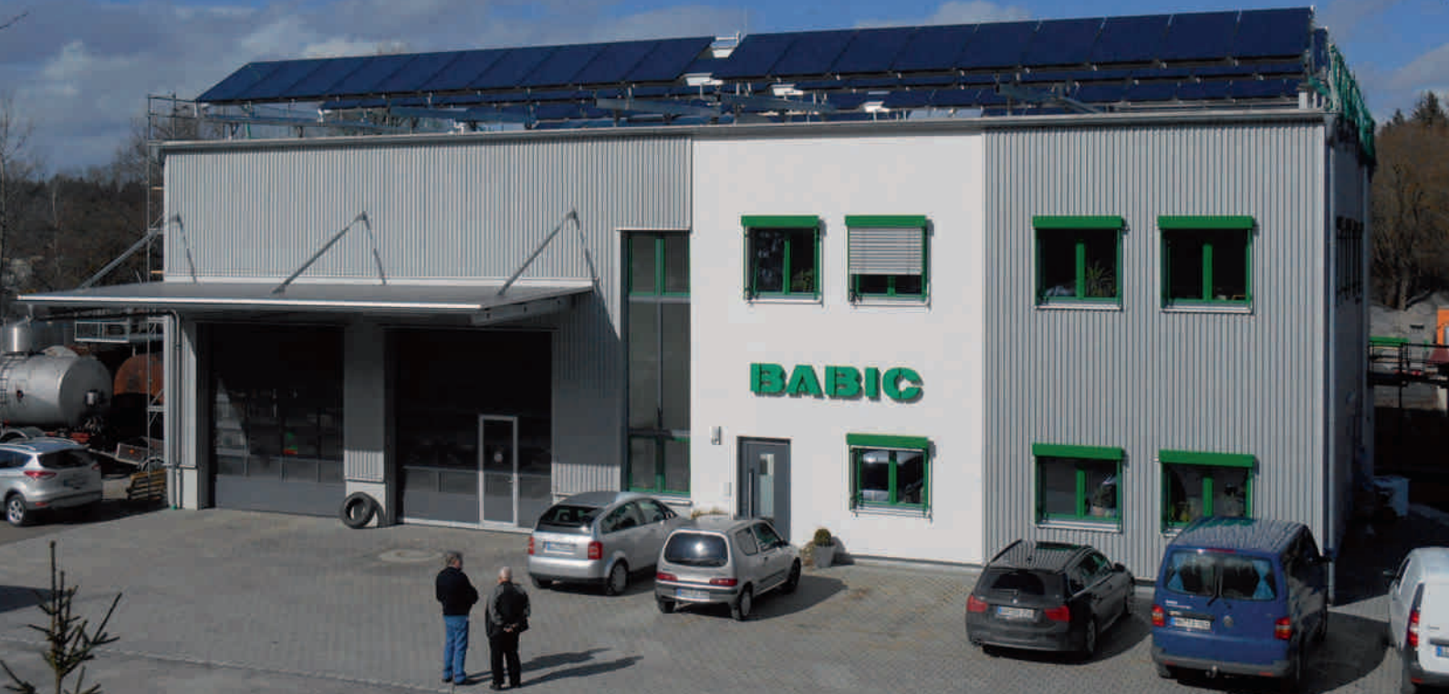
1.91 Quadratmeter Kollektorfläche unterstützen die Produktion der Bitumenemulsion.
