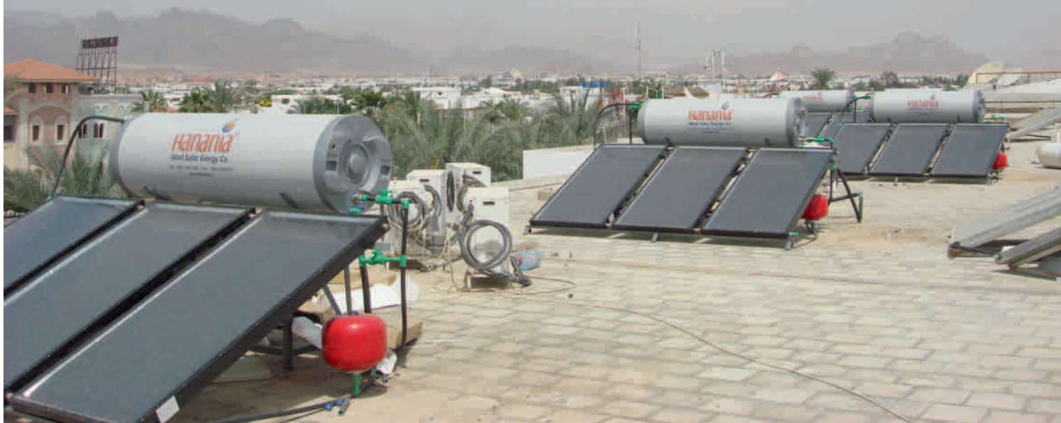
Schwerkraftsysteme wie hier in Jordanien sind die verbreitetste Form der Solaranlage weltweit. FOTO: IDEAL SOLAR ENERGY
