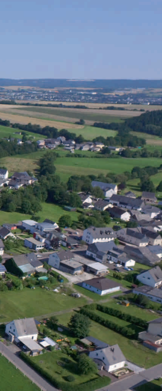
Die Hunsrückgemeinden Neuerkirch und Külz werden seit 2016 mit Wärme aus einer 1.422 Quadratmeter großen solarthermischen Anlage mit Wärme versorgt. FOTO: RITTER XL SOLAR
