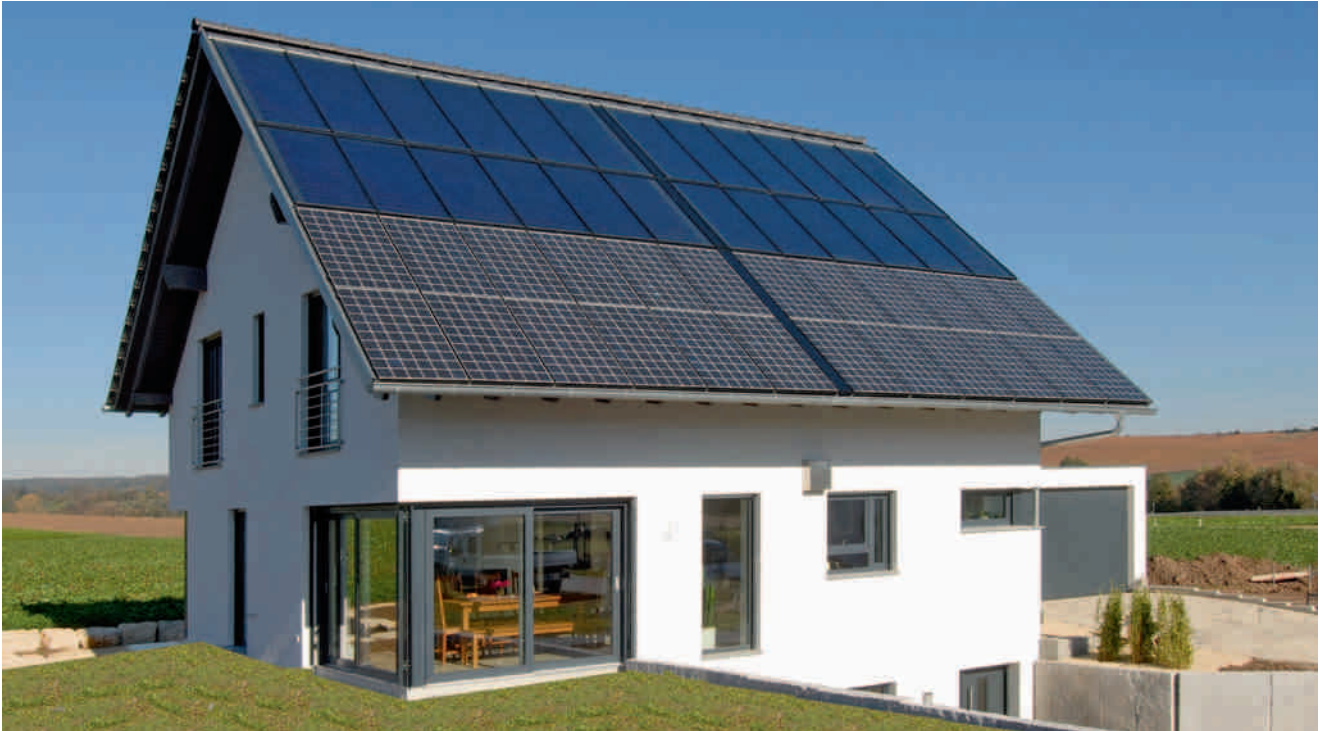
In speziellen Solarsystemen werden Solarkollektoren und Photovoltaikmodule mit dem gleichen Raster kombiniert und anschließend in das Dach integriert.
