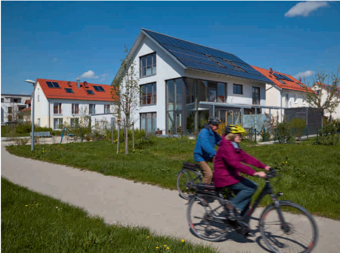
Eine Reihe mit Sonnenkollektoren reicht im Sonnenhaus von Familie Schuster, um 60 Prozent des Heizbedarfs zu decken. PV-Module belegen die restlichen zwei Drittel der Dachfläche.
