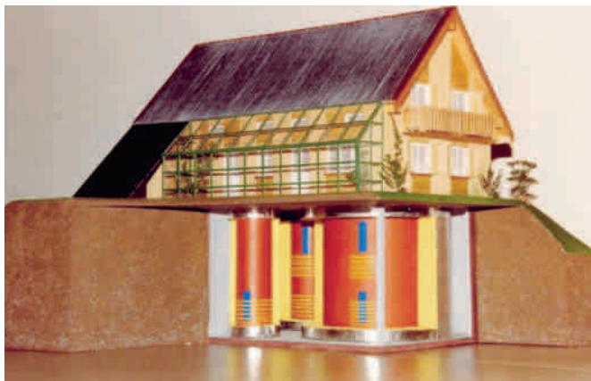
Drei Wasserspeicher mit insgesamt 118 m 3 Fassungsvermögen speichern die Solarwärme im Oberberger Sonnenhaus.
