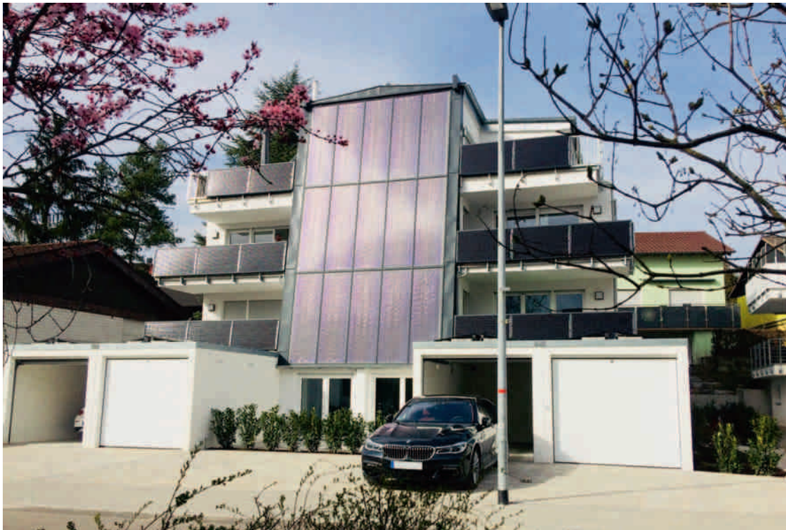
Bei diesem Mehrfamilienhaus mit sechs Wohnungen in der Nähe von Heilbronn erzeugen Solarthermie- und Photovoltaikanlagen Solarenergie für Wärme, Strom und Elektromobilität. FOTO: KHB-CREATIV WOHNBAU
