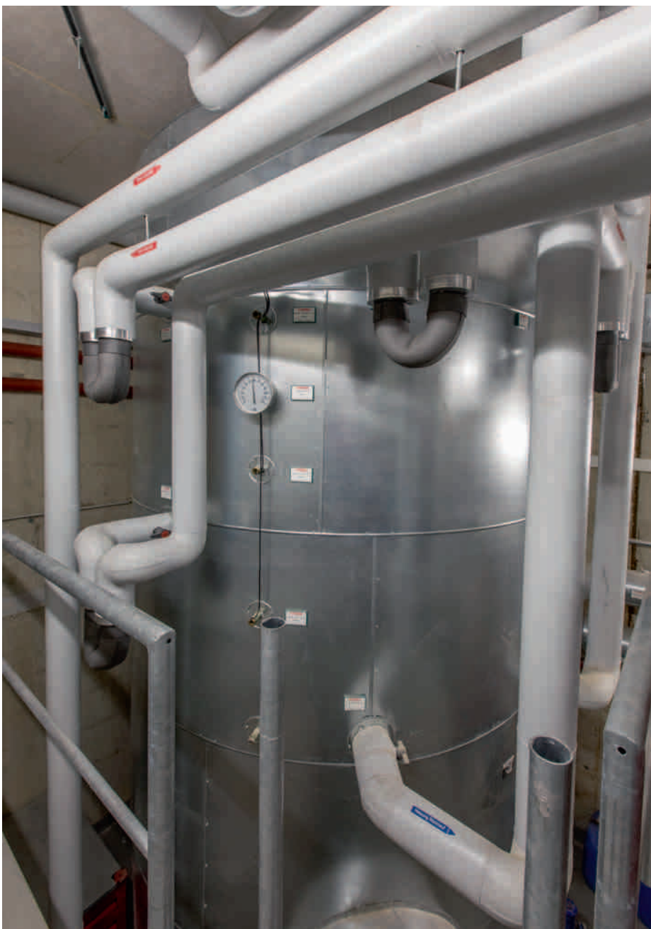
In jeder der beiden Heizzentralen speichert ein 14.000 Liter fassender Wärmertank die Energie, die Pelletskessel und Sonnenkollektoren liefern.
