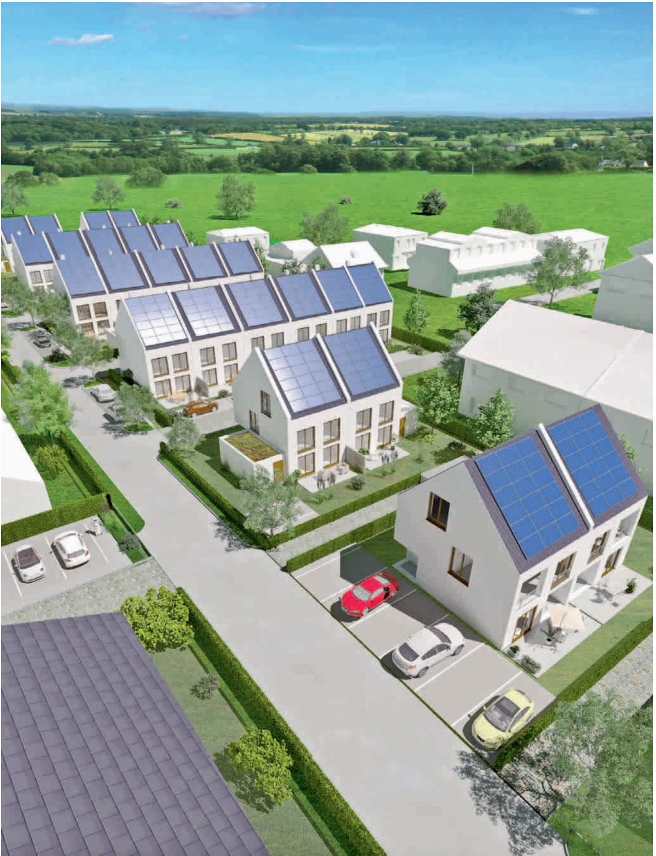
Wohnbau der Zukunft: Citrin Solar plant, in Moosach eine neue Siedlung über ein Leitungsnetz mit Sonnenwärme vom nahegelegenen Firmendach zu versorgen. Auf den Hausdächern selbst wird Photovoltaik installiert.
