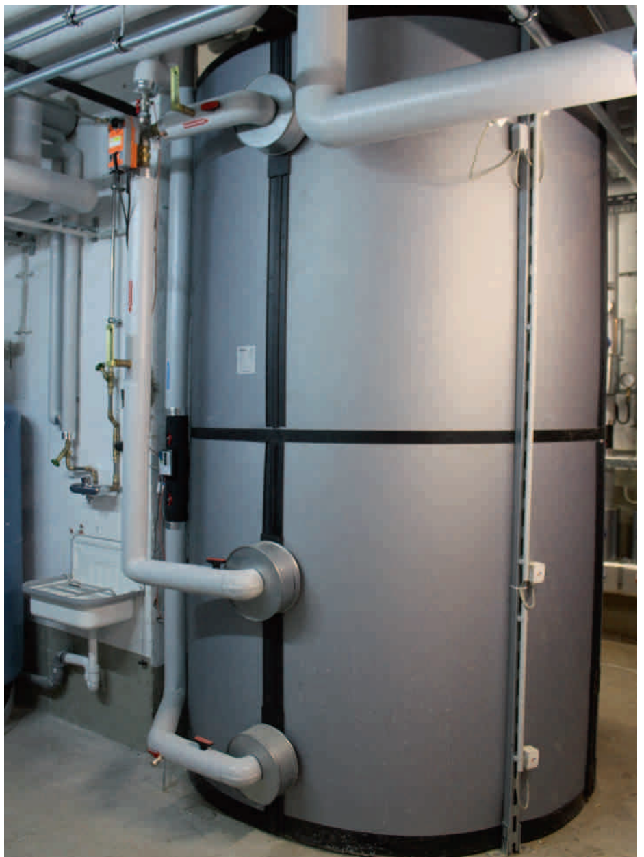
Unten: Ein 5.500 Liter großer Pufferspeicher sammelt die Solarwärme für die Wohnanlage des Bauvereins Giesing.
