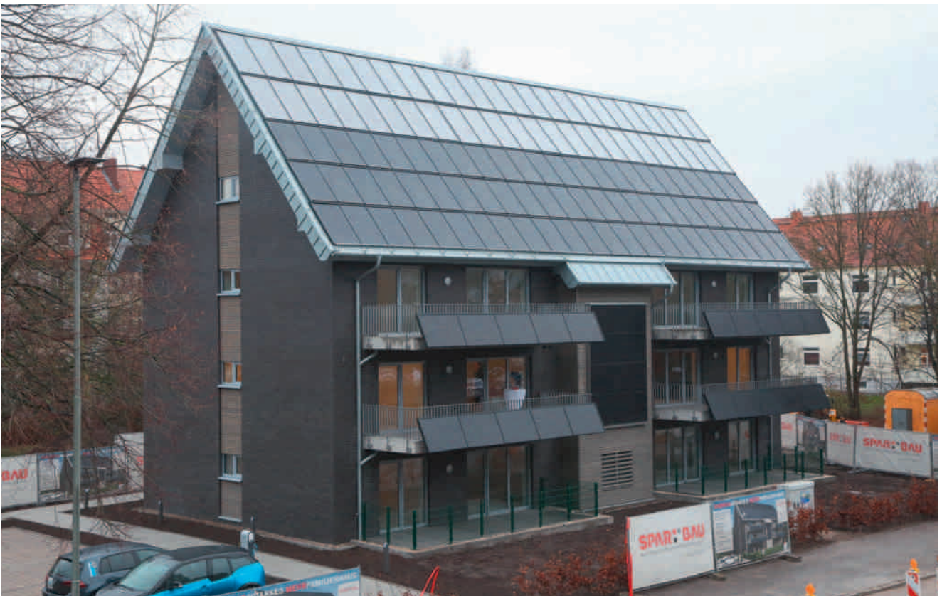
Dank großer Solarthermie- und Photovoltaik-Anlagen auf dem Dach, an der Fassade und an den Balkonen werden bei dem energieautarken Mehrfamilienhaus in Wilhelmshaven rund 70 Prozent des Energiebedarfs für Wärme und Strom solar erzeugt.
