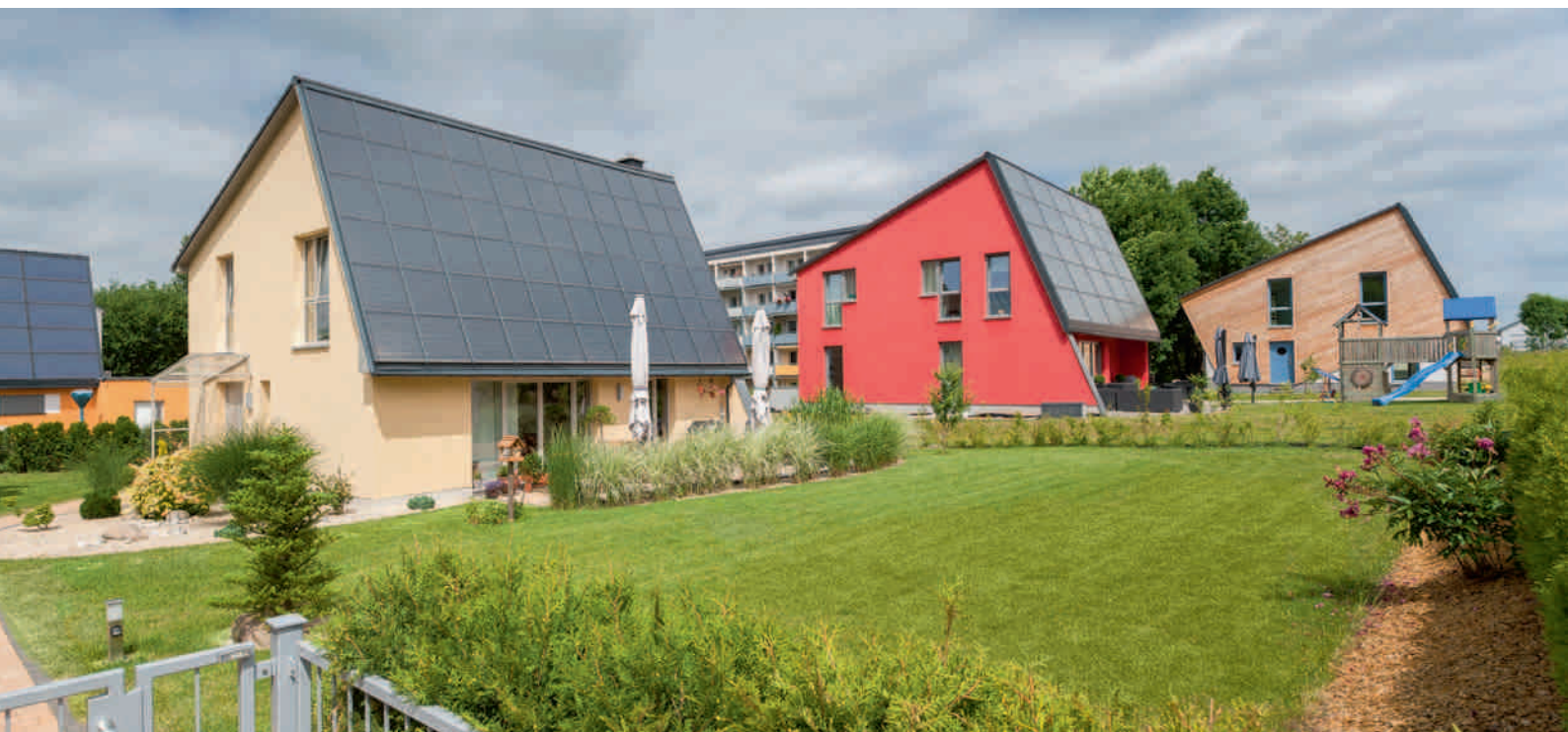
Auf dem ehemaligen Rittergut Rabenstein hat FASA eine Siedlung mit Aktivsonnenhäusern errichtet. FOTO: ULF DAHL
