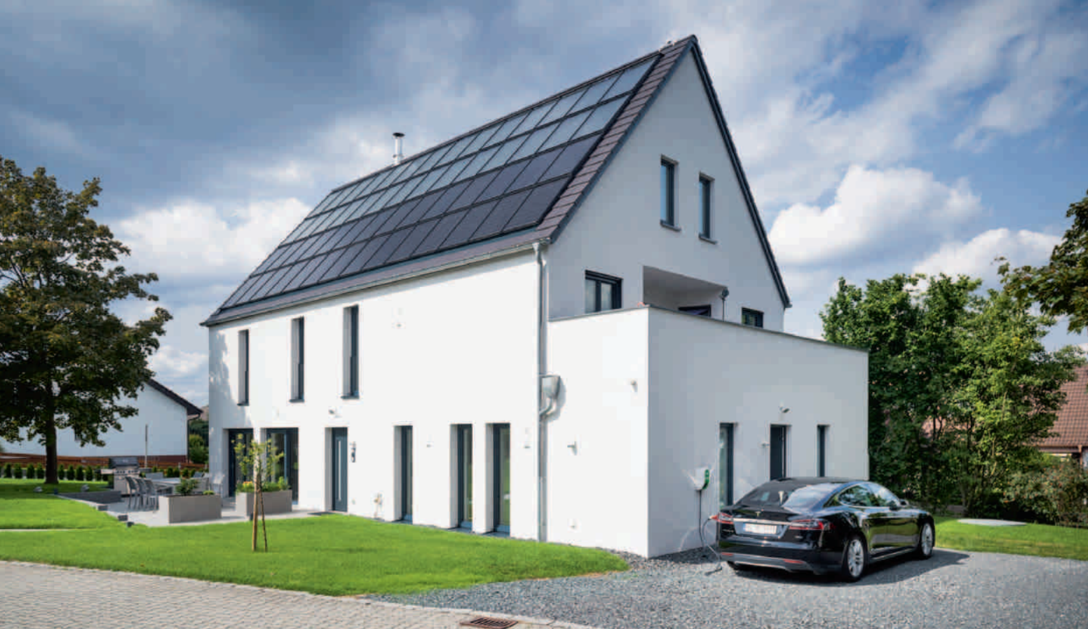
In Sonnenhäusern der neuen Generation werden Solarthermie- und Photovoltaikanlagen kombiniert, um hohe Autarkie bei Wärme, Strom und Elektromobilität zu erzielen.
