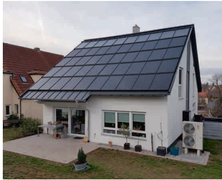
Im Projekt SolSys messtechnisch untersuchtes Gebäude in Heilbronn. Durch die Kombination von Photovoltaik und Solarthermie wird ein jährlicher gesamt solarer Deckungsanteil, das heißt für Wärme und Strom, von 62 Prozent erreicht.
