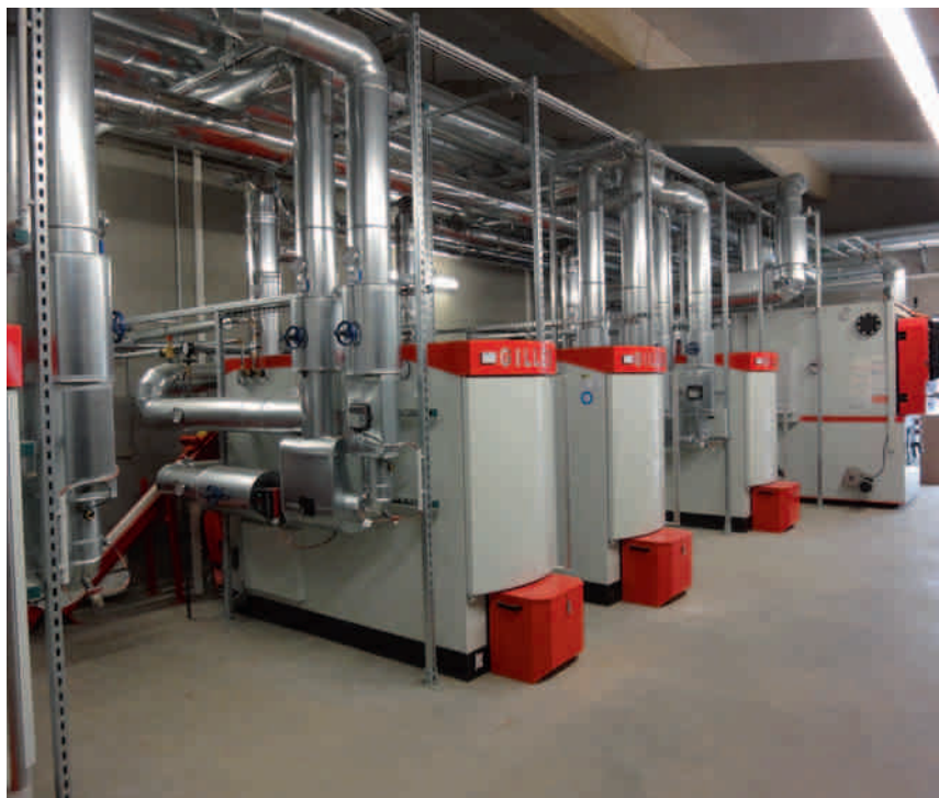
Vier Holzkombikessel ergänzen die Wärmeversorgung, wenn die Sonne nicht ausreichend scheint.
