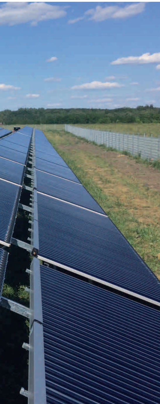
Das Kollektorfeld in Senftenberg besteht aus Vakuumröhrenkollektoren mit einer Gesamtfläche von 8.300 m 2 .
