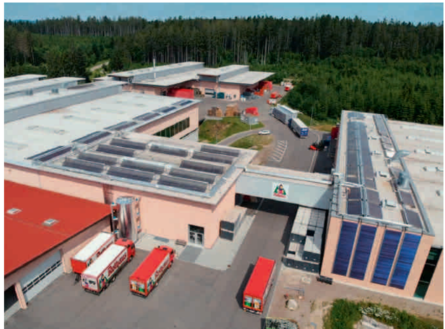
Seit April 2018 braut die Badische Staatsbrauerei Rothaus ihr Bier mit Hilfe einer solaren Prozesswärmeanlage. Die Anlage ist eine der größten solarthermischen Dachanlagen in Deutschland.
