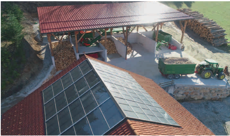
Die solare Trocknung von Hackgut ist 25-mal so effektiv wie die Photovoltaik.
