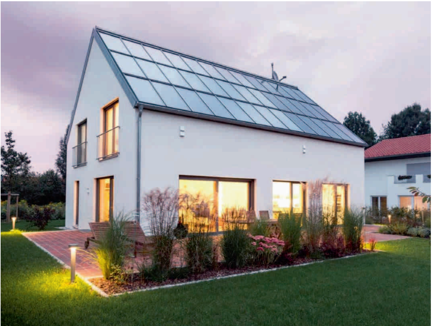
Beim Effizienzhaus Plus in Burghausen sind prognostizierte und gemessene Energiewerte fast deckungsgleich. Das Gebäude wurde monolithisch mit perlitverfüllten Poroton-Ziegeln errichtet. Die Wärme wird vor Ort sowohl in der Baukonstruktion als auch im thermischen Speicher gelagert.
