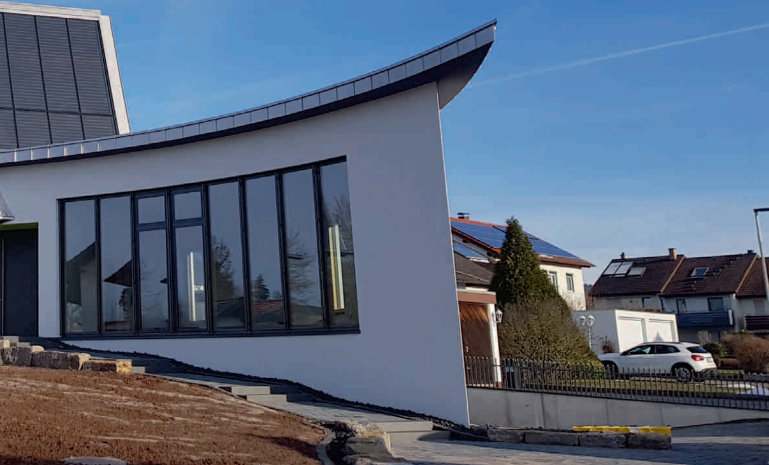
FOTOS (14): HARTMANN ENERGIE TECHNIK
