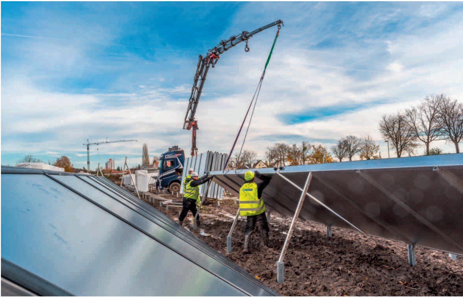
Errichtung der Kollektoren für die Solare Fernwärme in Ludwigsburg: Rund ein Drittel der solarthermischen Wärmeleistung wird in Zukunft für die Versorgung der Wärmenetze benötigt.
