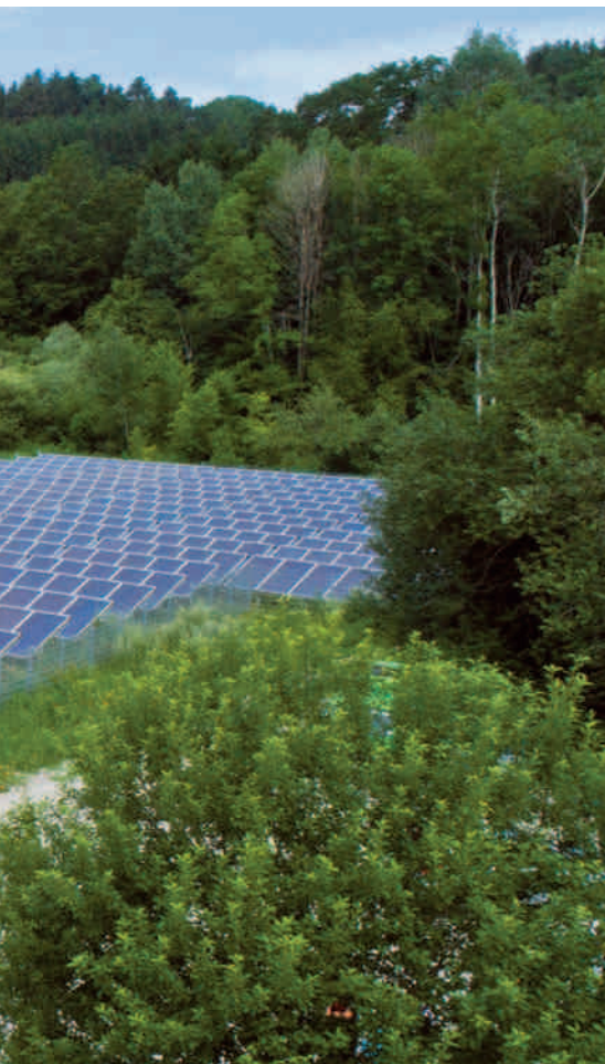
In Moosach liefern Holzhackschnitzel und Solarthermie die Wärme für 70 private und kommunale Anschlussnehmer eines Wärmenetzes.
